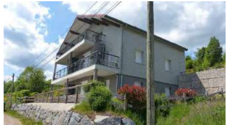
Mur cyclopéen de soutènement pour le rez-de-chaussée et un mur de soutènement en bloc bétons aspect pierre pour l'arrière du terrain
