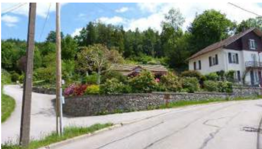
Mur de soutènement en petits moellons
