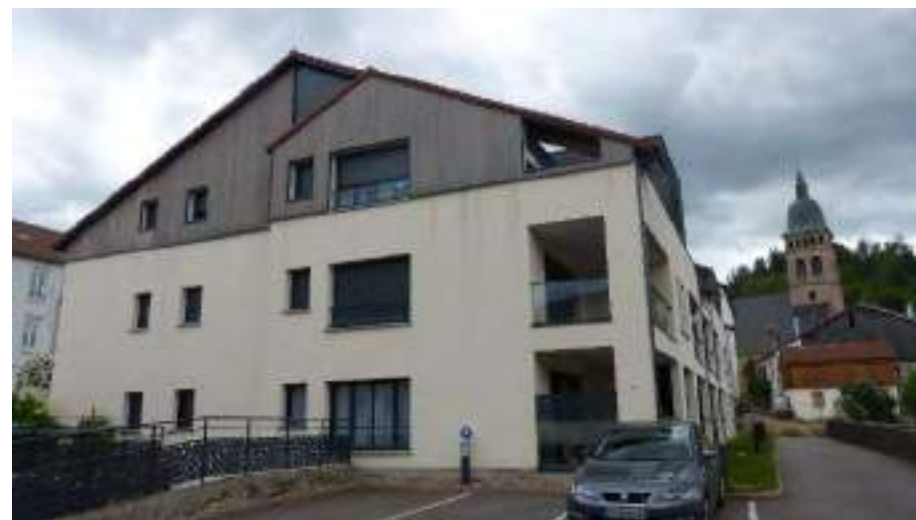
Le volume massif à proximité de l'église et de la mairie s'impose dans la ruelle partiellement renouvelée où il est implanté et tranche avec le centre ancien adjacent
