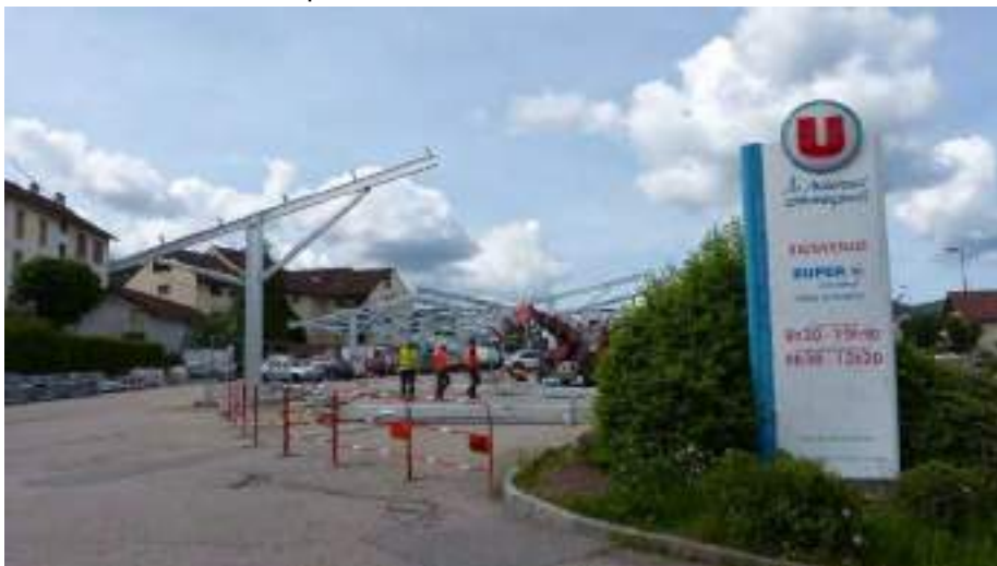
Parking du Super U en rénovation
