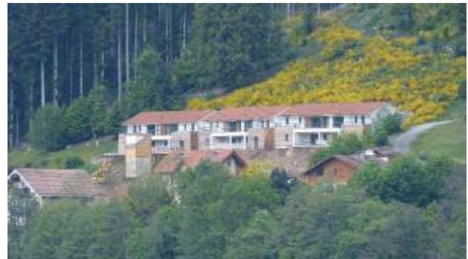
Habitat intermédiaire en construction au bord du lac
