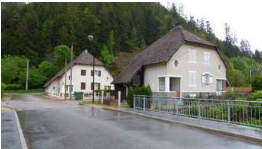
L'entrée du lotissement de maisons doubles
