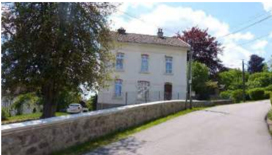
La brique en linteau de fenêtre dans une villa
