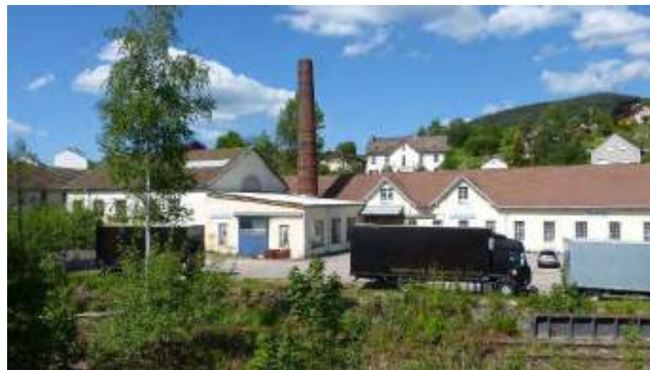
cheminée en briques
