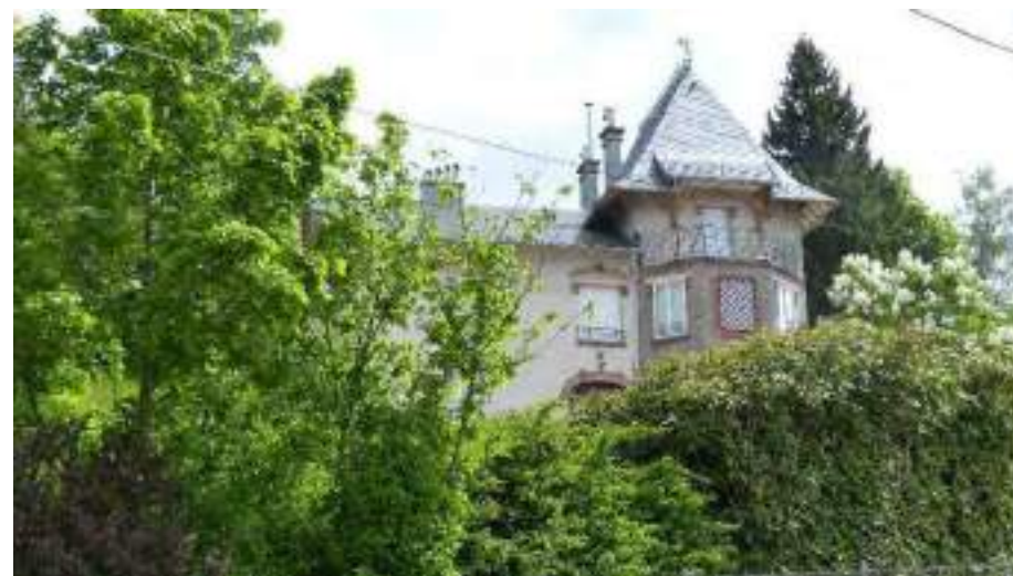
Encorbellement avec balcon en fer forgé et aisseliers arqués
