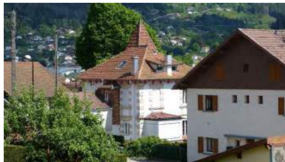
Villa avec modénatures, aisseliers, encorbellement, épi de faîtage et frise de faîtage
