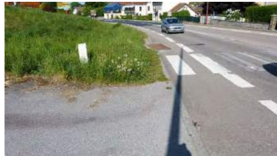
Un passage piéton sur la RD 417 donnant sur l'entrée d'une maison et non sur un trottoir
