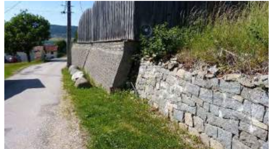
Mur de soutènement réhaussé d'une palissade bois
