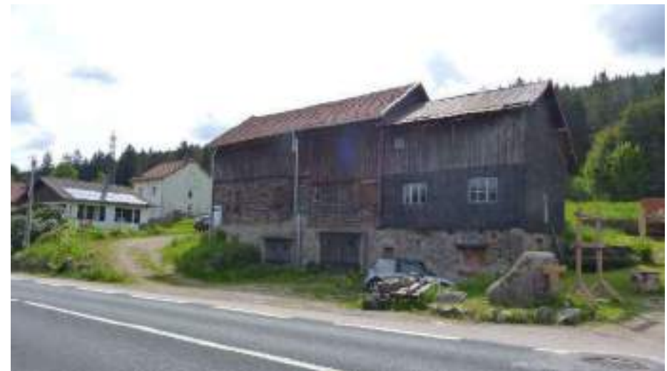
Bardage bois et tôle sur un soubassement en granit
