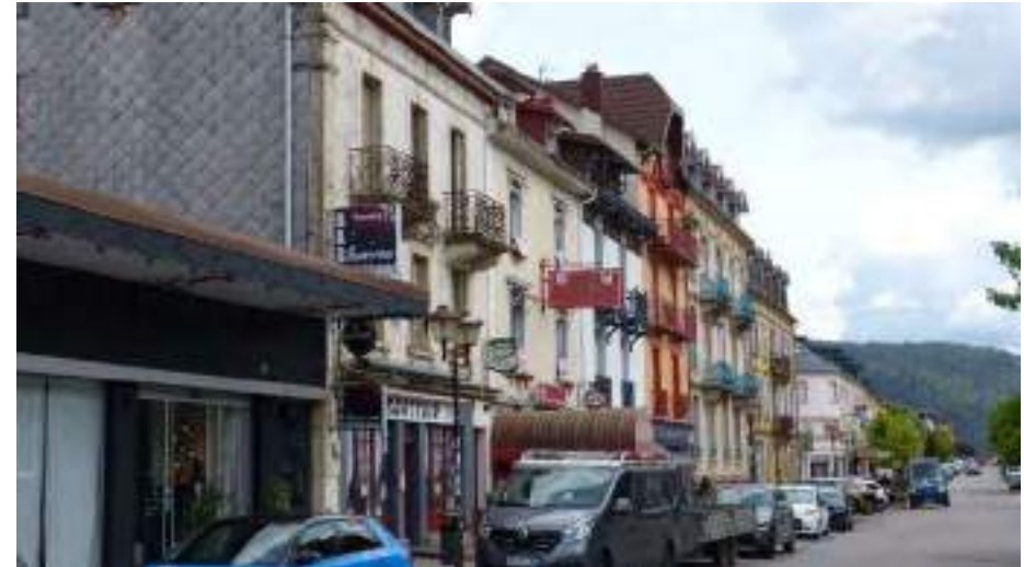
Bardage fibrociment complété par endroit par de la tôle
