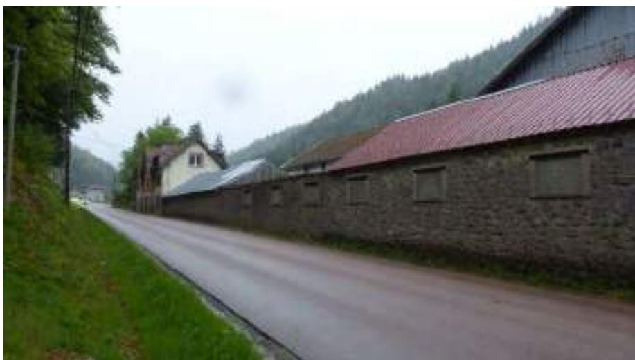
Le mur de l'ancienne papèterie, partiellement réhabilitée
