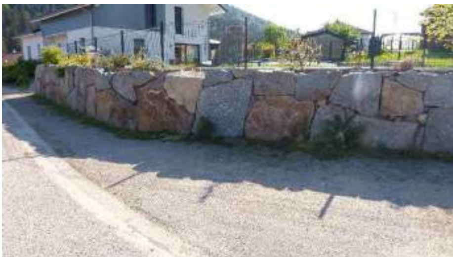
Mur cyclopéen pour niveler le terrain
