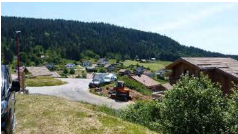
Résidences secondaires en cours de construction dans le secteur du Rond Fain
