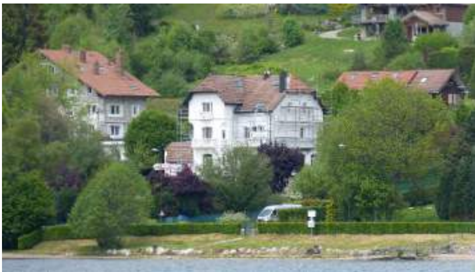
Une villa en bord de lac en rénovation
