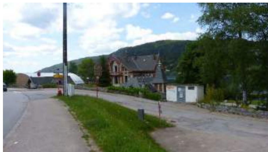
La villa Monplaisir, une des rares constructions avec façades en briques
