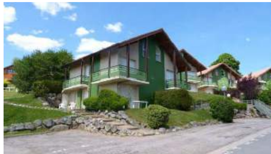
Granit qui sert de soutènement au chemin et au terrain
